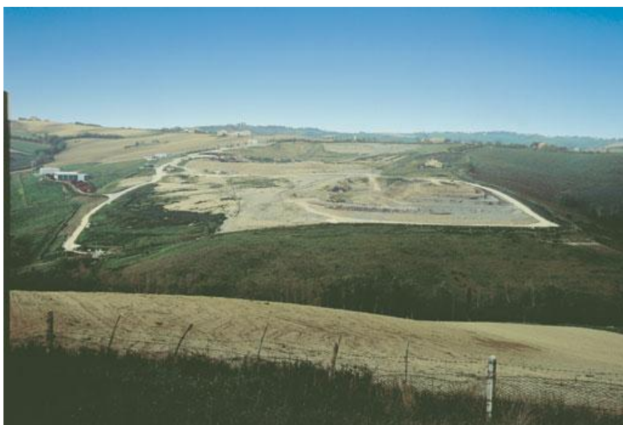
Fig. 16 - Vista panoramica della discarica
